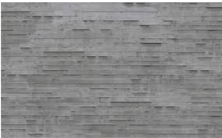
Ruw beton tijdens de weg omlaag. Het begin van de route is nog makkelijk, maar wordt al snel ruwer en scherper.
